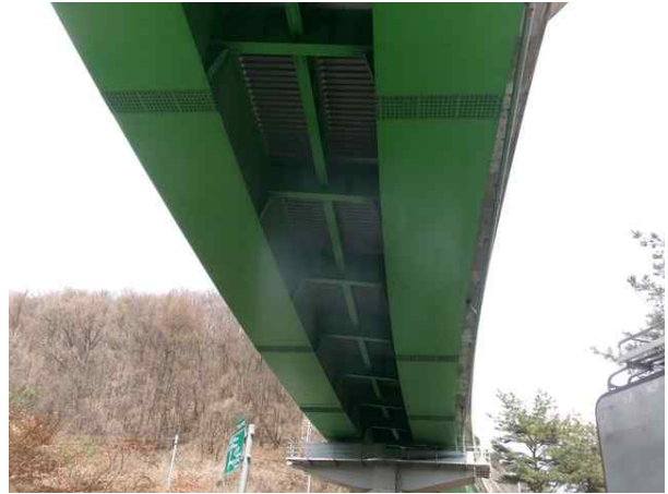
바닥판 하면 및 거더 전경
