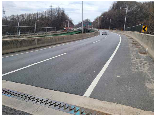
교량 상부 전경
